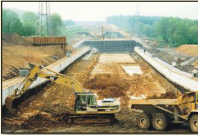
Bodenaushub im Rahmen von Baumaßnahmen
