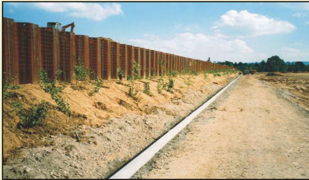
Einsatz von Bodenmaterial bei der Herstellung einer Lärmschutzwand
