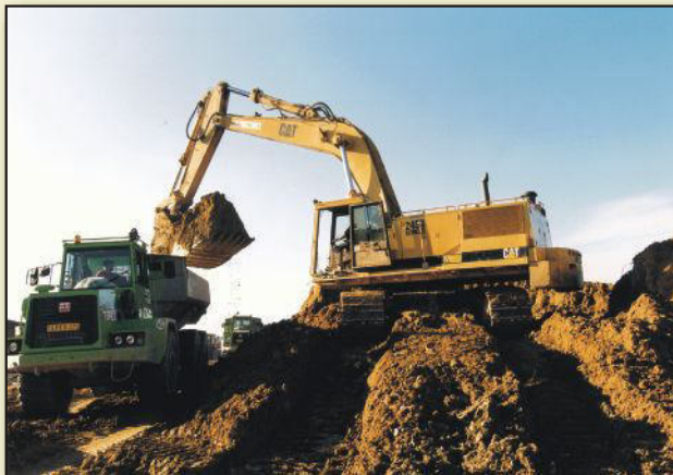
Aushub von Bodenmaterial
