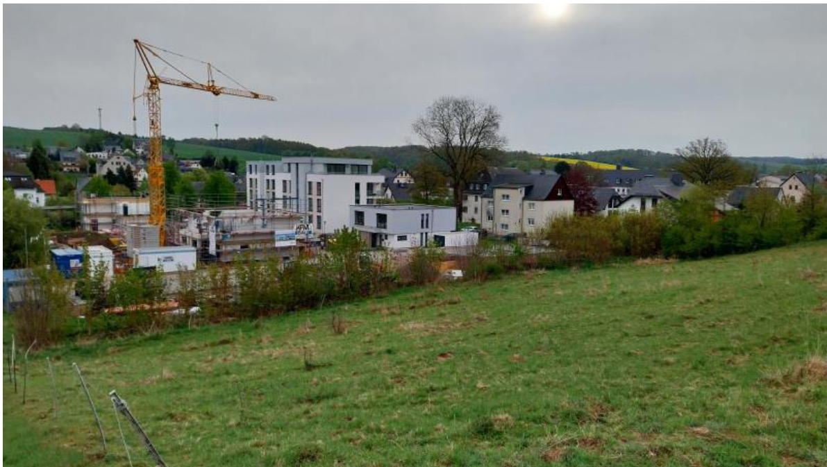
Abbildung 5: Blick aus dem nördlichen Zentralteil der Fläche zu den aktuellen Bauarbeiten
