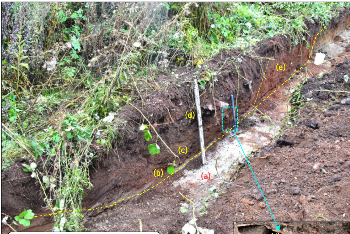
Abb. 7: Suchschlitz M-3 im Bereich Mühlgraben
